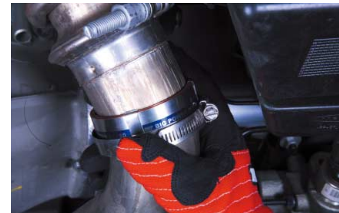
こちらは排気用。作業を依頼した世田谷の「オートマックス」は原則としてSEV取付工賃が無料。今回の3アイテムで作業時間は10分程度だった。
